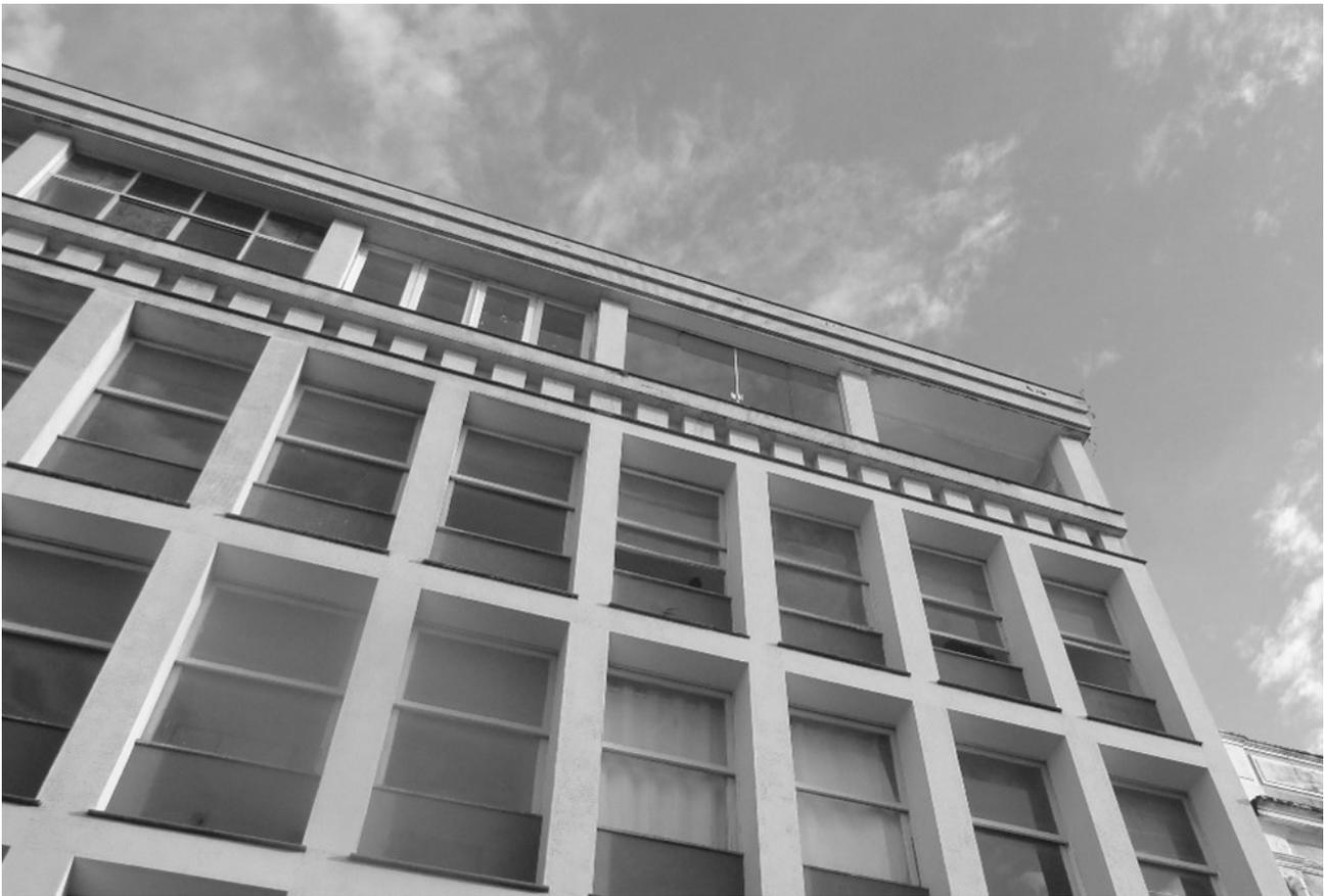
Foto da fachada do Edifício SULACAP com destaque a esquadrias que foram substituídas das originais. Fonte: Autoria própria.
