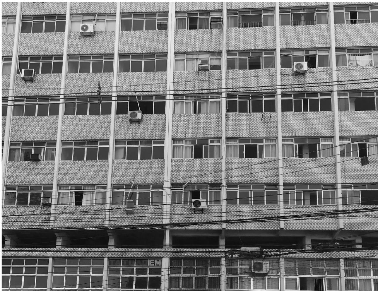
O pavimento tipo se forma por uma junção de doze configurações de diferentes tipos de plantas. Em seu projeto original o edifício contava com uma área vazada destinada ao uso comum dos condôminos, atualmente ocupada por escritórios comerciais. Destaca-se nesse projeto, o material de revestimento das fachadas, conhecido como pó de pedra, e a torre de escadas que tem sua resolução em forma elíptica com fechamento através de elementos vazados conhecidos como cobogós (SILVA, 1981).
