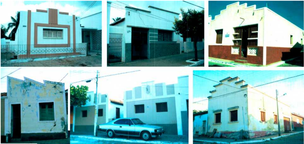
Figura 3 : Imagens de casas na cidade de Currais Novos entre 1996 e 1998. Destaque para platibandas recortadas e uso de frisos como adornos. Fonte: Trigueiro, et al, 2005.
