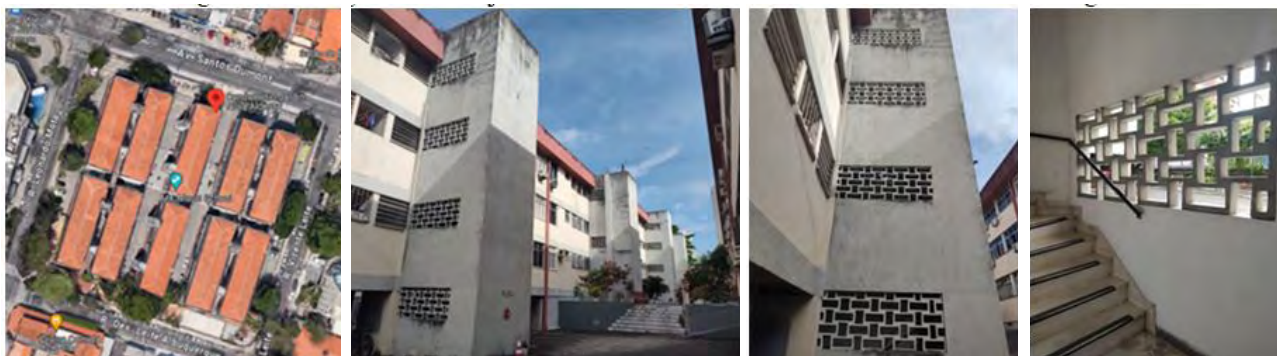
Figura 7: Vistas gerais do conjunto residencial e detalhes da caixa de escada com cobogós. Fonte: Google Earth e acervo das autoras.
