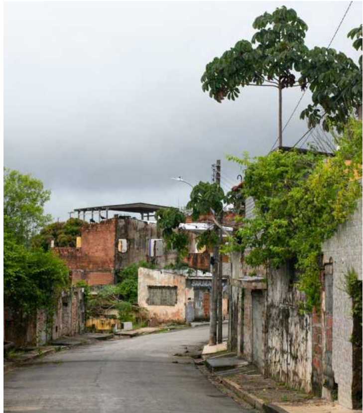
Figura 2: Situação atual dos bairros e suas residências, quando ainda não foram demolidas estão totalmente arruinados.
