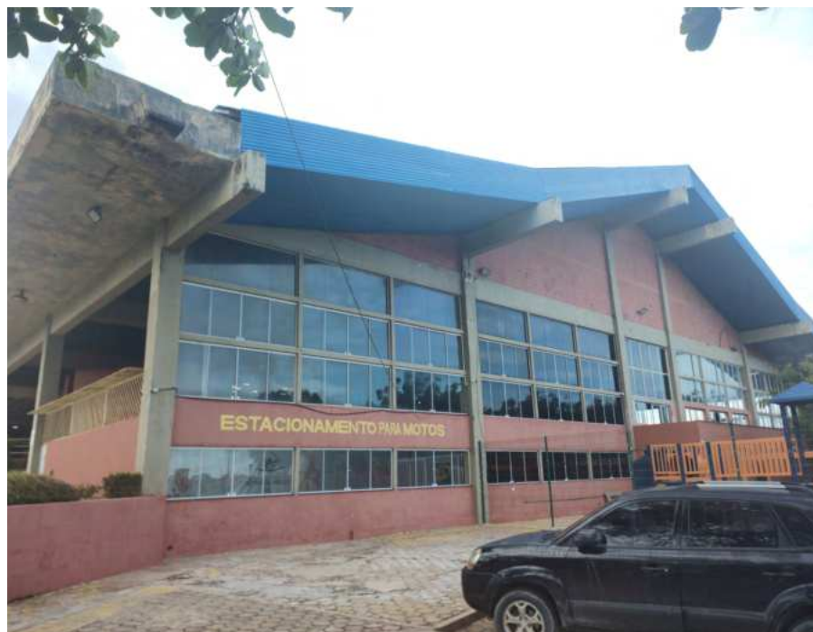
Figura 05 – Fachada frontal do Salão Principal do APCEF/MA. Fonte: Próprio autor, 2022.
