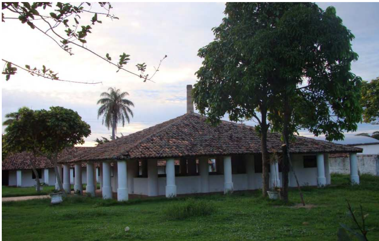
Figura 2 – Mercado da Carne - Aquiraz. Fonte: Foto dos autores
