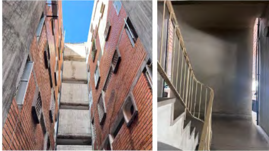
Figura 7: Vista externa e interna dos painéis de concreto armado da área comum. Fonte: Acervos dos autores, 2024.
