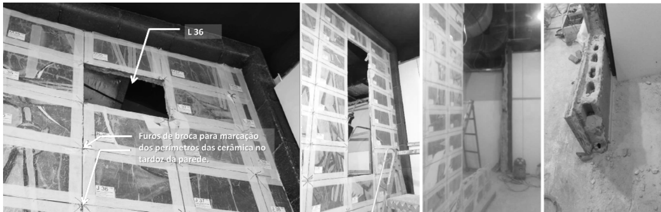
FIGURA 14: Retirada pedra a pedra, sem perda da geometria das cerâmicas.FONTE: autores.
