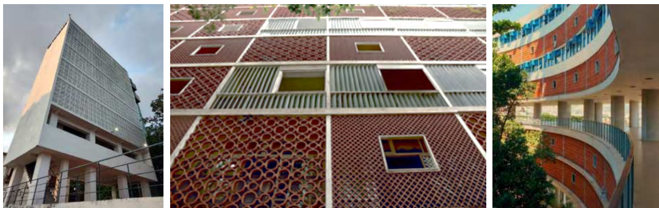
Figura 01- Caixa d'água de Olinda(1936), Edifícios do Parque Guinle (RJ) e Conj. Residencial Pedregulho (RJ).
