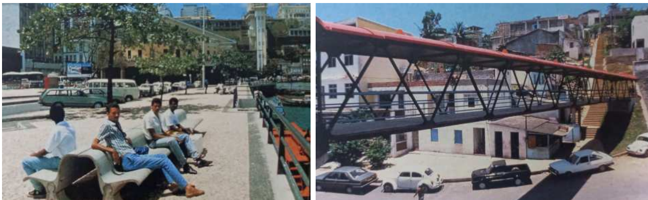
Figura 7: Lado Esquerdo - Banco com encosto em argamassa armada/ Lado direito - Passarela para pedestres em aço. Fonte: Latorraca, 2000.
