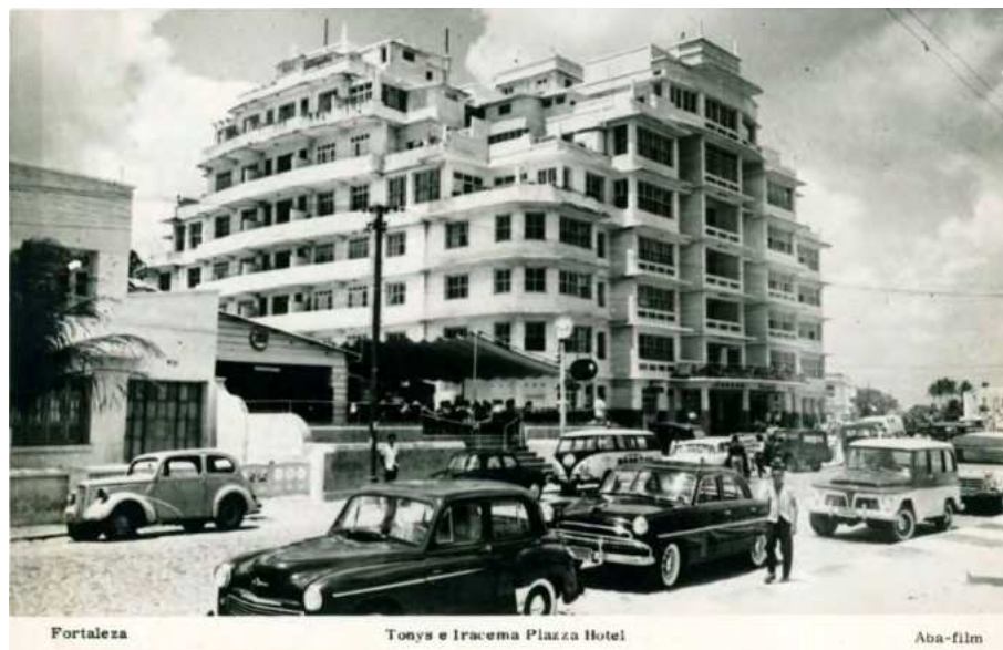
Figura 5 - Edifício São Pedro, também conhecido por Iracema Plaza Hotel. Fonte: Biblioteca do IBGE 5 .
