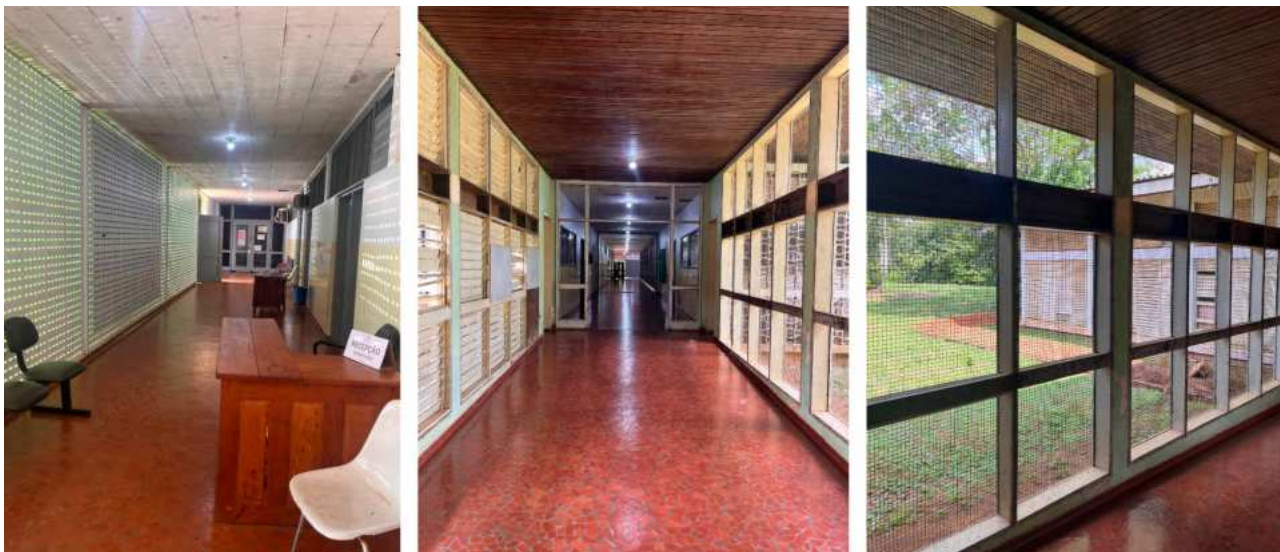
Quadro 5: Quadro com as vistas do corredor do Hospital de Serra do Navio, detalhes para os elementos vazados presentes na edificação, presença de telas na vedação dos elementos arquitetônicos para a proteção de insetos.
