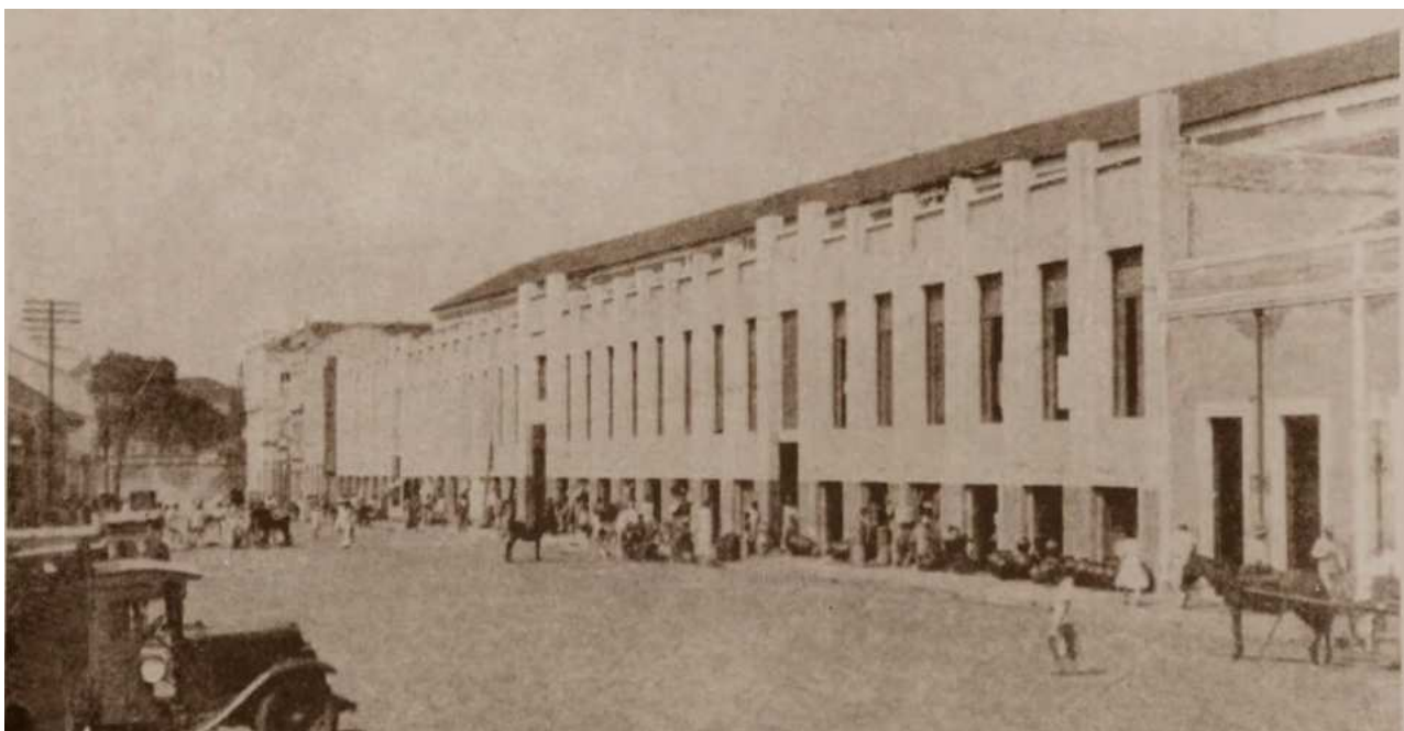
Figura 4 – Prédio Mercado Municipal de Fortaleza, construído em 1932. Fonte: Acervo Prefeitura Municipal de Fortaleza.
