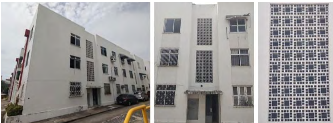
Figura 9: Visão do conjunto residencial e detalhes do hall de escada com cobogós. Fonte: Acervo das autoras.
