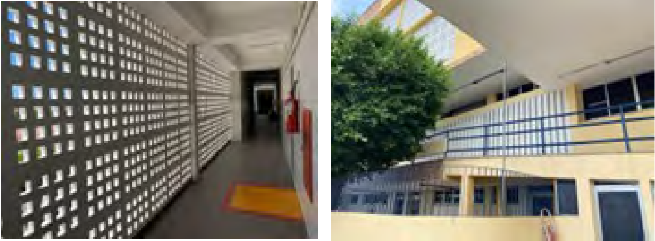
Figura 5: Proteção da fachada poente: balanço, cobogó e brises. Fonte: Farias (2011) e arquivo pessoal do autor (2020).
