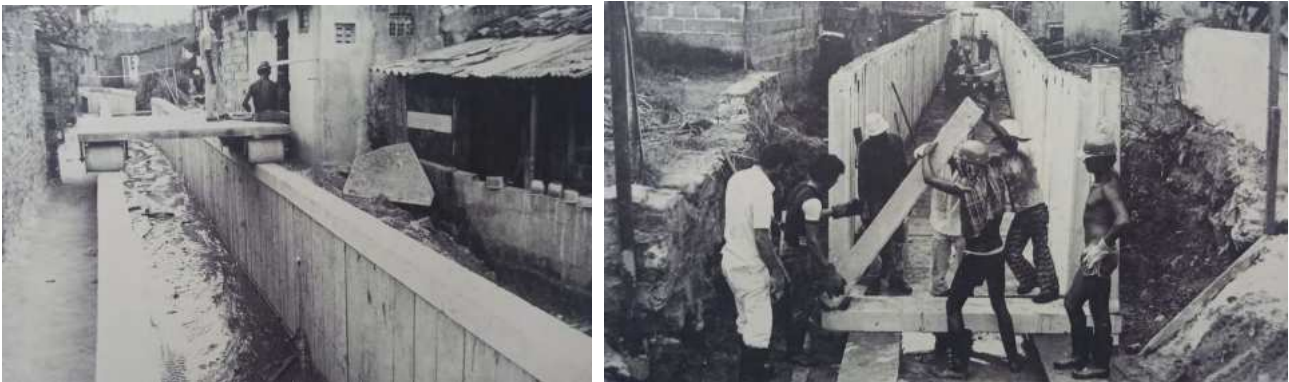
Figura 5: Peças pré-fabricadas sendo implementadas para a construção de um canal de drenagem em Salvador. Fonte: Latorraca, 2000.
