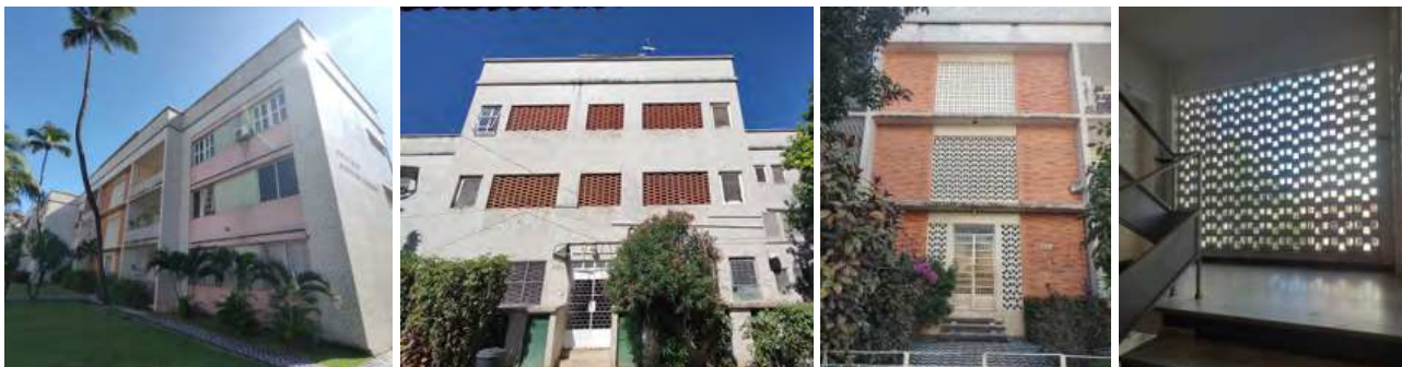
Figura 3: Fachadas Nascente e Poente - Detalhes dos painéis de cobogós do acesso principal (visão externa e interna). Fonte: Acervo das autoras.
