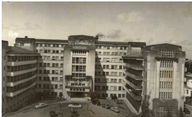
Figura 2. Antigo Hospital das Clínicas, inaugurado em 1948. Fonte: Acervo SUMAI (Superintendência de Meio Ambiente e Infraestrutura)/UFBA.
