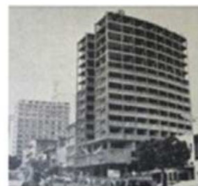
Imagem 44: Hugo Marques. Edifício Lucas (em construção), vendo-se o Edifício Rique, ao fundo (Fonte: Revista Tamboá, 1966).
