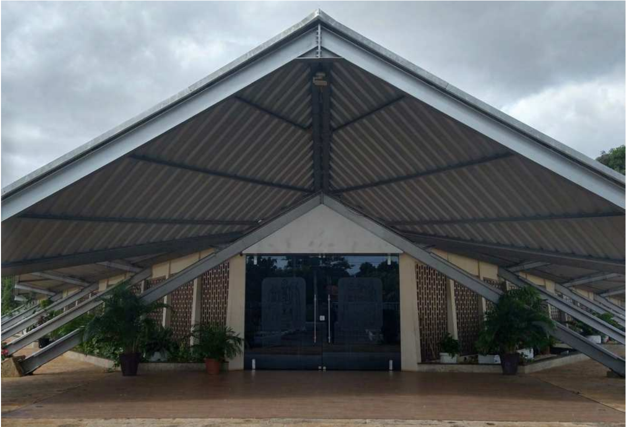
Figura 6: Átrio de entrada da Paróquia da Santíssima Trindade. Fonte: Wanderson Barbosa, 2023.
