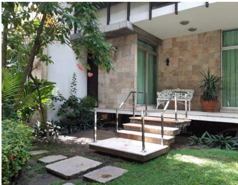
Figura 6: Vista da entrada social – térreo e subsolo da garagem. Fonte: Arquivo Alcyr Meira (2021).
