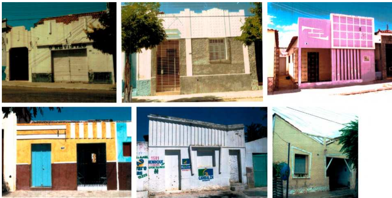
Figura 6: Dois primeiros exemplos, da esquerda para a direita e debaixo para cima, temos edificações na cidade de Caicó. As demais são na cidade de Cruzeta. Fotos tiradas entre os anos de 1996 e 1998. Fonte: Trigueiro, et al, 2005.
