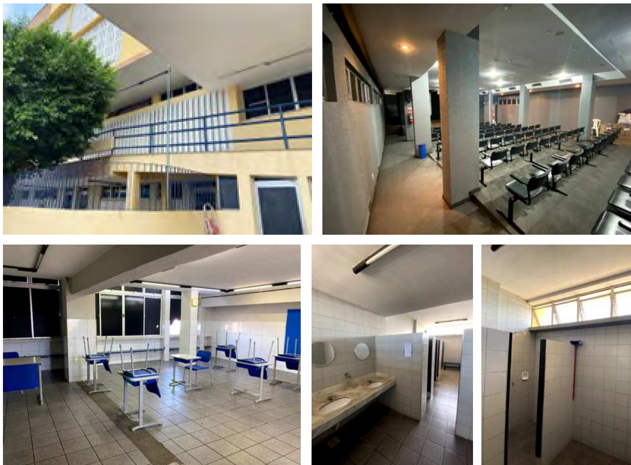
Figura 9: Brises verticais na fachada, curva de visibilidade no auditório, demolição de divisória e eliminação da varanda e instalação de banheiros. Fonte: Arquivo pessoal do autor (2020).
