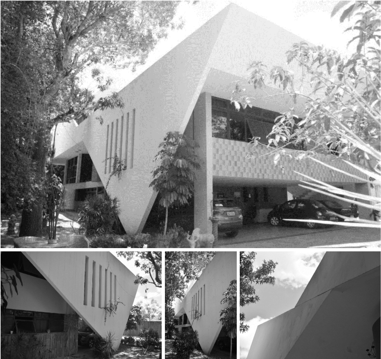
Figura 7: Empena e pilares da garagem. Fonte: Autor, 2022.
