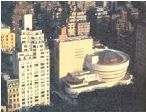
Figura 17 Relação da adição com as edificações do entorno
