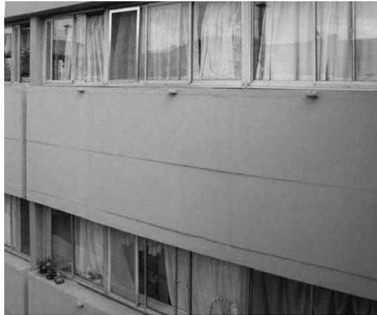
Fig. 20: Carpintería de aluminio y marcas de los moldes (Fuente: <sup>18</sup>)
