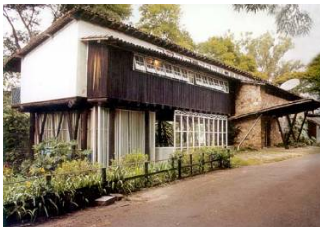
Figura 4 – Fachada sul - foto anterior a 2004
