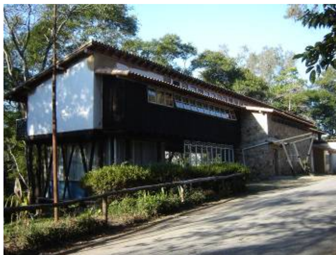
Figura 6 – Fachada sul - Julho de 2006
