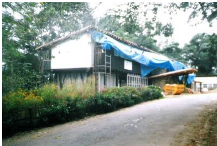
Figura 5 – Fachada sul - Julho de 2004
