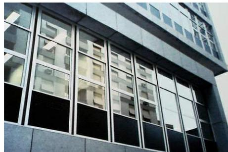
Figura 37. Depois: o revestimento de granito com a estereotomia marcada por juntas com selante à base de poliuretano, e as esquadrias novas de alumínio.
