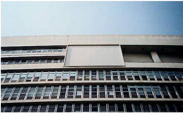
Figura 38. Antes: as linhas de esquadrias da ala norte (à esq.) do 6° e 7° pavimentos trazidas até à fachada, ocupando os terraços; o mural oeste e os quebra-sóis inexistentes.
