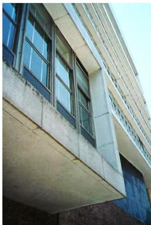
Figura 36. Antes: o revestimento existente de pastilhas com a estereotomia marcada também por pastilhas, porém de cor cinza escuro, e as esquadrias antigas.
