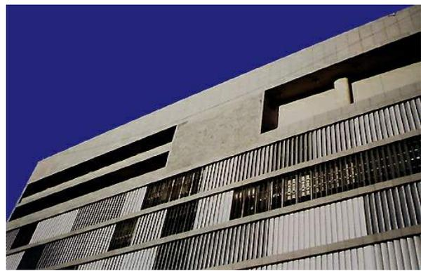
Figura 39. Depois: a linha das esquadrias voltou ao limite dos terraços abrindo o vão aberto coberto da extensão do restaurante; o mural e os quebra-sóis já instalados.
