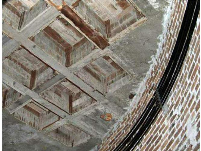
Figura 21. Base da laje tipo caixão à mostra, corresponde à fôrma da ala norte do 1º pavimento.
