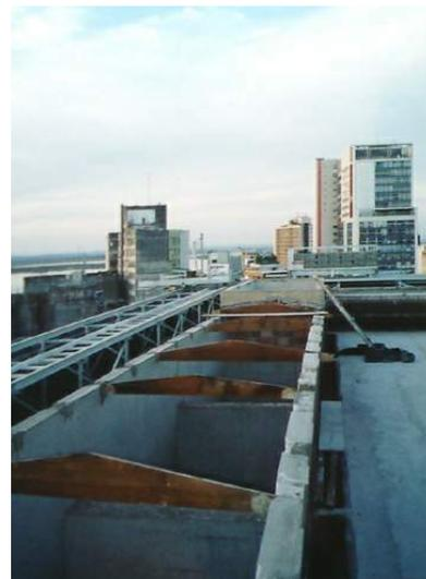
Figura 26. Durante a obra: o telhado sendo retirado para posterior limpeza, recuperação das pastilhas de revestimento e colocação dos domos de acrílico
