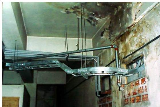
Figura 14. 8º pav. com as infiltrações e a extensão das instalações de telefonia antes da reforma
