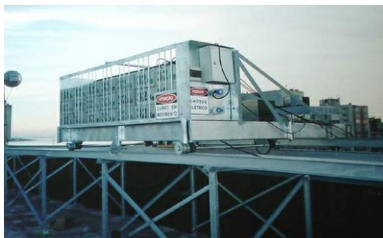
Figura 40. O sistema de contrapeso do andaime elétrico, fixado na cobertura, que corria paralelamente à platibanda.
