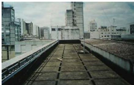
Figura 25. Antes: o sistema de pilaretes e placas e o telhado de fibrocimento sobre a ala norte do 7º pav.
