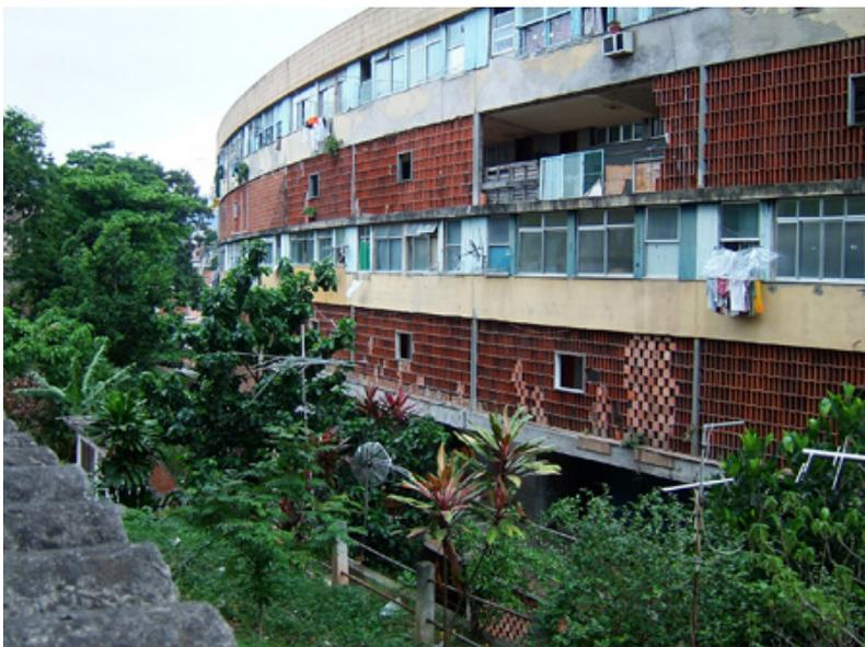
Figura 6 – Fachada norte do bloco A em avançado estado de
