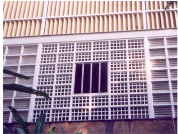
Figura 16 – Detalhe do fechamento de vão com esquadria de alumínio
