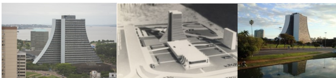
Figura 9 – Centro Administrativo do Estado do Rio Grande do Sul – Fernando Ferrari. Esquerda – Zona sul ao fundo. Direita – Vista desde o Largo dos Açorianos. Fonte: <http:// www.skyscrapercity.com> Acesso em 24 mai. 2009, 22:01:00. Meio – Maquete do conjunto. Fonte: Acervo Cairo Albuquerque da Silva
