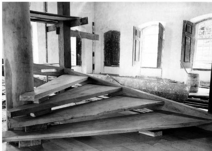
A escada atada à estrutura existente sendo construída degrau a degrau
