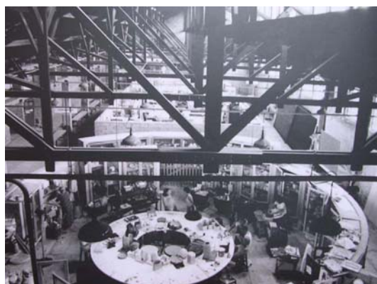
Figura 6 – Galpão dos ateliês – Sesc-Pompéia – 2000
