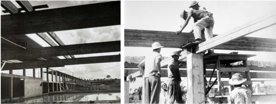
Figs. 11 e 12: Imagens da construção do Clube de Regatas Jaó, Goiânia, c.1963
