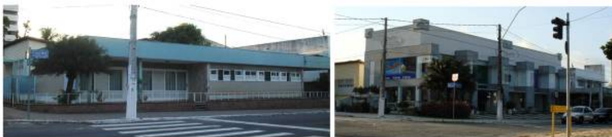
Figura 10: Demolição da edificação anterior e substituição por novo imóvel de apelo pós-moderno.
