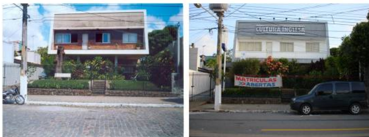
Figura 7: Edificação relativamente preservada, mas com alteração do uso. * Fonte: Mário Rodrigues.
