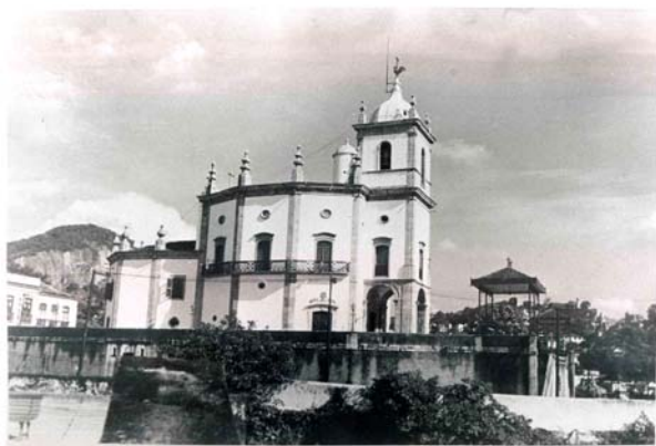
Figura 04: Vista externa da igreja antes da restauração. Notar a varanda lateral corrida com gradil de ferro, os dois coretos nos ângulos do adro e o embasamento sem caiação branca. Aos fundos aparecem parcialmente as casas pertencentes à Irmandade da Glória, posteriormente unificadas em um só volume.
