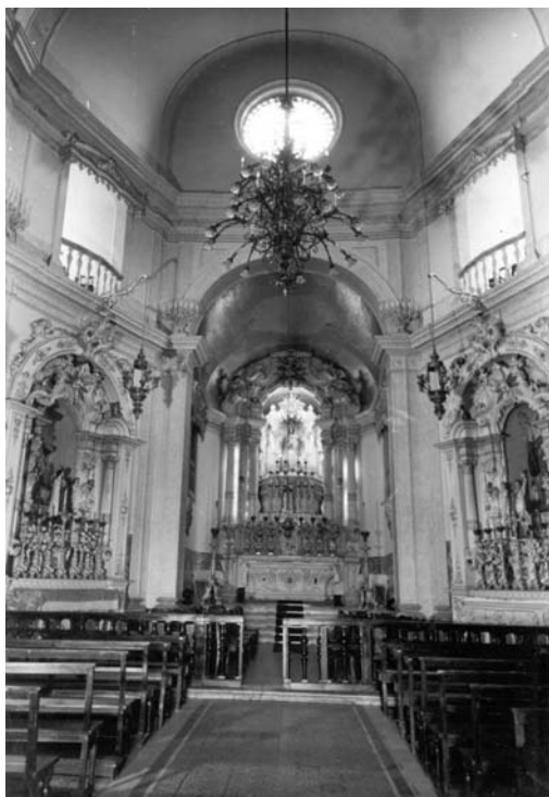
Figura 03: Interior da igreja antes da restauração. Notar o lustre central, o óculo com vitral sobre o arco-cruzeiro, o piso de ladrilhos hidráulicos, as peças de cantaria pintadas de branco e todos os elementos de talha pintados de branco com filetes dourado (inclusive o retábulo do altar-mor).
