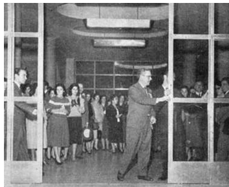
Figura 08: Vista interna da Sala Fahrion em direção ao Hall, percebe-se a iluminação do hall e ao fundo a esquadria do Salão Social Fonte: Revista do Globo, fascículo 727 pg. 45
