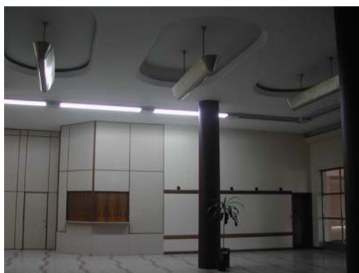
Figura 19 : foto do Hall no 2º pav. Atual situação com a presença de divisórias e frisos de madeira.
