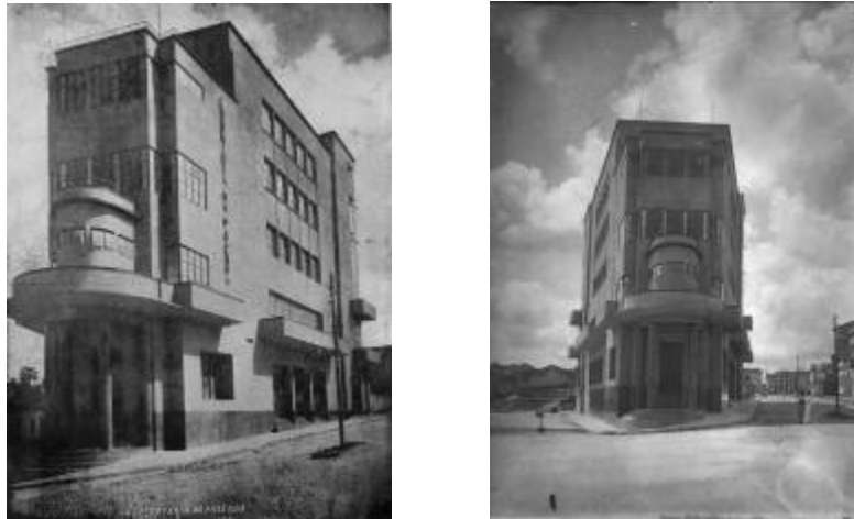
Figura 2 - Situado em lote triangular o prédio assume tal formato curvando-se na esquina. A solução gera terraços escalonados que dinamizam a composição.
