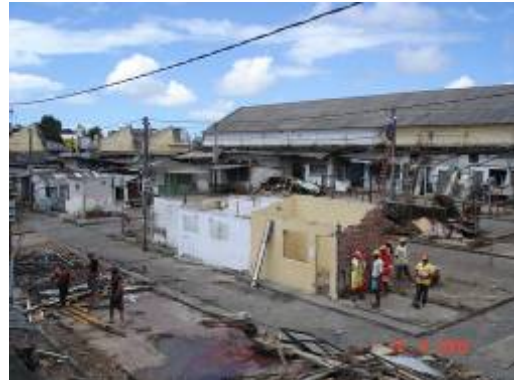
Figura 11 – Demolição da antiga Quadra G
