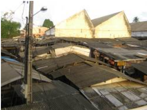
Figura 10 – Vista geral da antiga Quadra G
