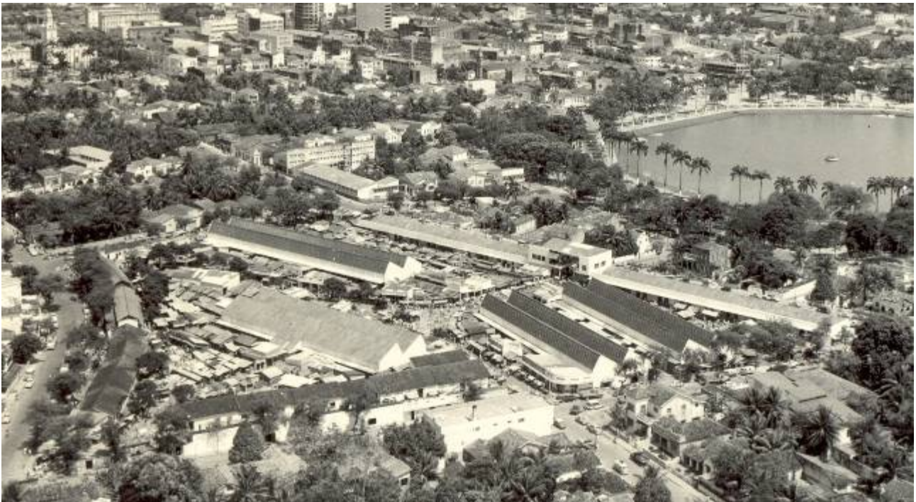
Figura 5 - A ocupação densa, a redução dos passeios públicos e desfiguração dos antigos galpões só fizeram se intensificar, levando a prefeitura municipal a desconsiderar todo o conjunto deixando sua administração fragilizada e sem promover qualquer manutenção na sua infra-estrutura.
