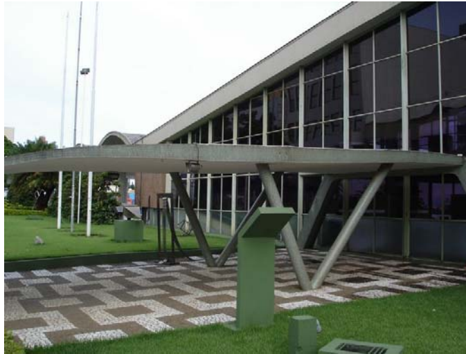
Foto 5 – Entrada pela fachada sul. Fonte: PISANI, Maria Augusta Justi Pisani (2006)
