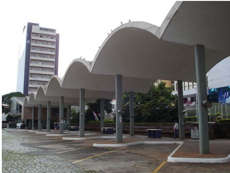
Foto 4 – Cobertura em casca na forma de abóbada. Fonte: Pisani, Maria Augusta Justi (2006)
