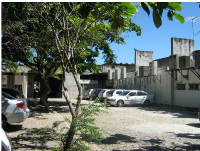
Figura 18: Vista dos fundos das agências bancárias. Absorção total das colunas. Fonte: os autores, 2007.
