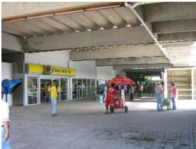
Figura 14: Vista da circulação principal destacando-se a atração exercida pelo espaço interno. Fonte: os autores, 2007.
