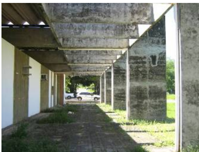
Figura 17: Vista dos fundos da galeria de arte.
