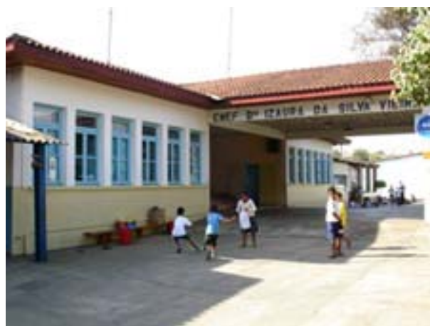
Figura 15 Salvador Candia, Grupo Escolar no Bairro de Cubatão, Itapira: bloco de administração entre salas de aula posteriores.
