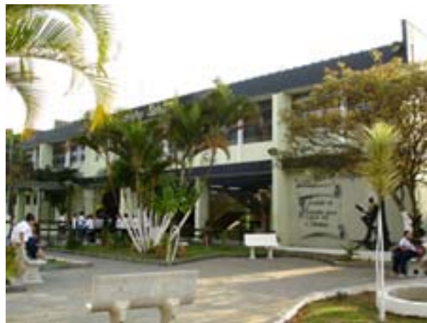
Figura 69 Maurício T. Schneider, Colégio Estadual e Escola Normal, Mauá: aspecto externo
