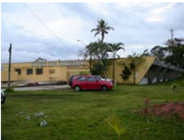
Figura 45 Vilanova Artigas, Ginásio, Itanhaém: fachada com depósito defronte painel artístico e portão emoldurado por elementos vazados
