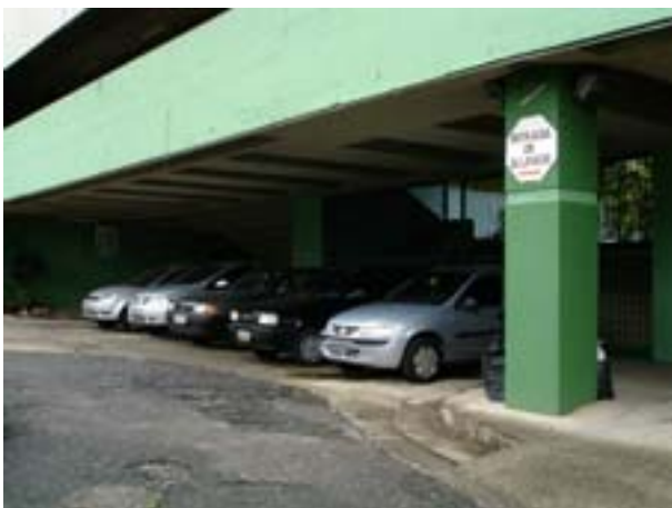
Figura 76 Vilanova Artigas, Ginásio de Utinga, Santo André: segregação da circulação de alunos
