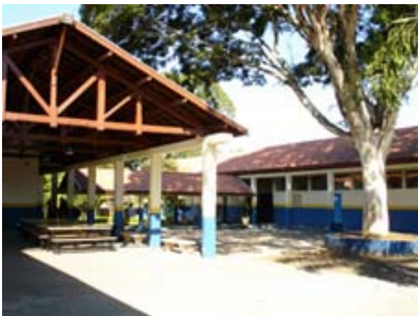
Figura 6 Carlos B. Millan e Galiano Ciampaglia, Grupo Escolar de Guedes, Jaguaruina: galpão sem palco (demolido)
