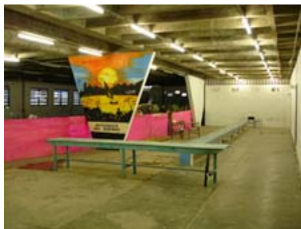
Figura 48 Vilanova Artigas, Ginásio, Itanhaém: aspecto galpão com salas de aula à dir. e ampliações precárias, em reforma (07/2006)
