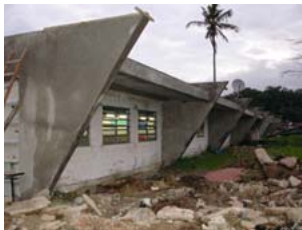
Figura 50 Vilanova Artigas, Ginásio, Itanhaém: paredes de salas ampliadas na área originalmente destinada ao galpão
