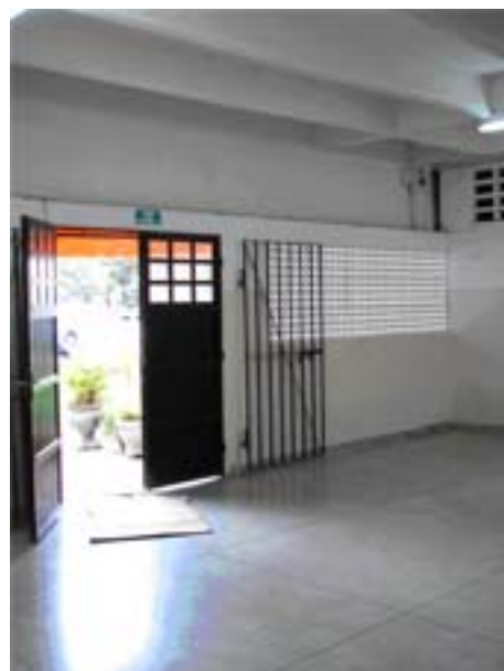
Figura 59 Abrahão Sanovicz, Grupo escolar Bairro Macuco, Santos: parede, portão e grade na fachada frontal
