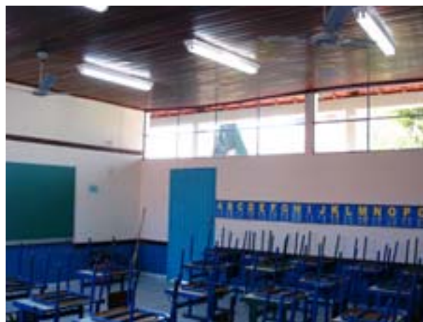
Figura 9 Carlos B. Millan e Galiano Ciampaglia, Grupo Escolar de Guedes, Jaguaruina: formato original das esquadrias das salas de aula
