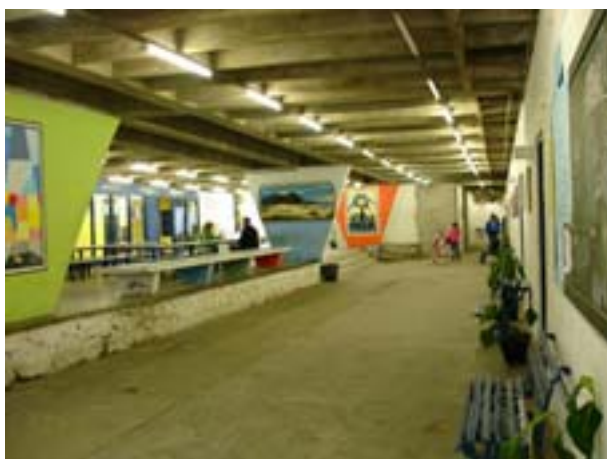
Figura 47 Vilanova Artigas, Ginásio, Itanhaém: circulação das salas de aula estrangulada pela ampliação, em andamento (em 07/2006), do bloco de sanitários
