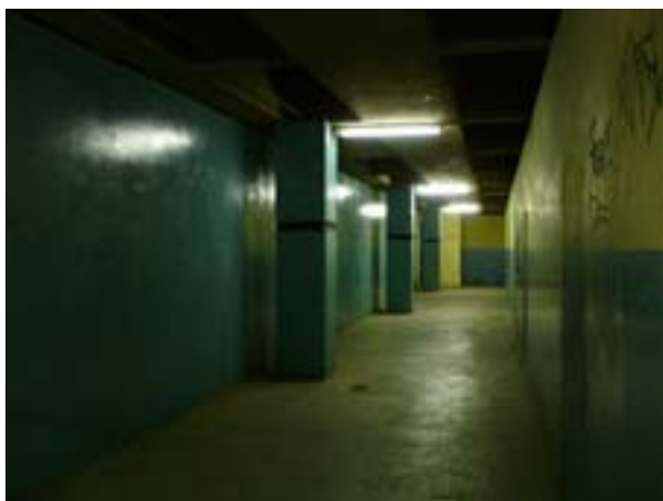
Figura 82 Vilanova Artigas, Ginásio de Utinga, Santo André: pavimento inferior tendo à dir. parede delimitando quadra de esportes na porção posterior do prédio
