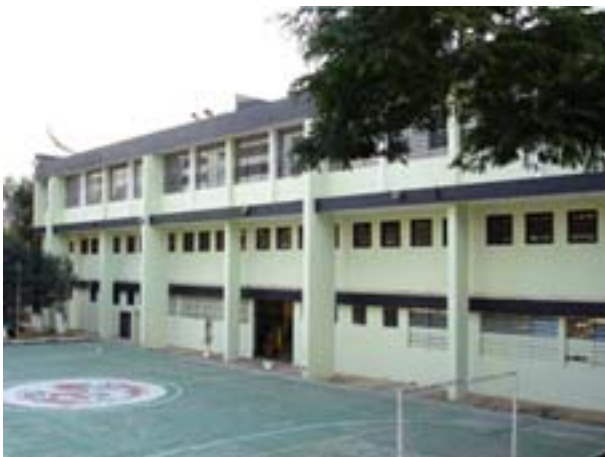
Figura 68 Maurício T. Schneider, Colégio Estadual e Escola Normal, Mauá: aspecto externo
