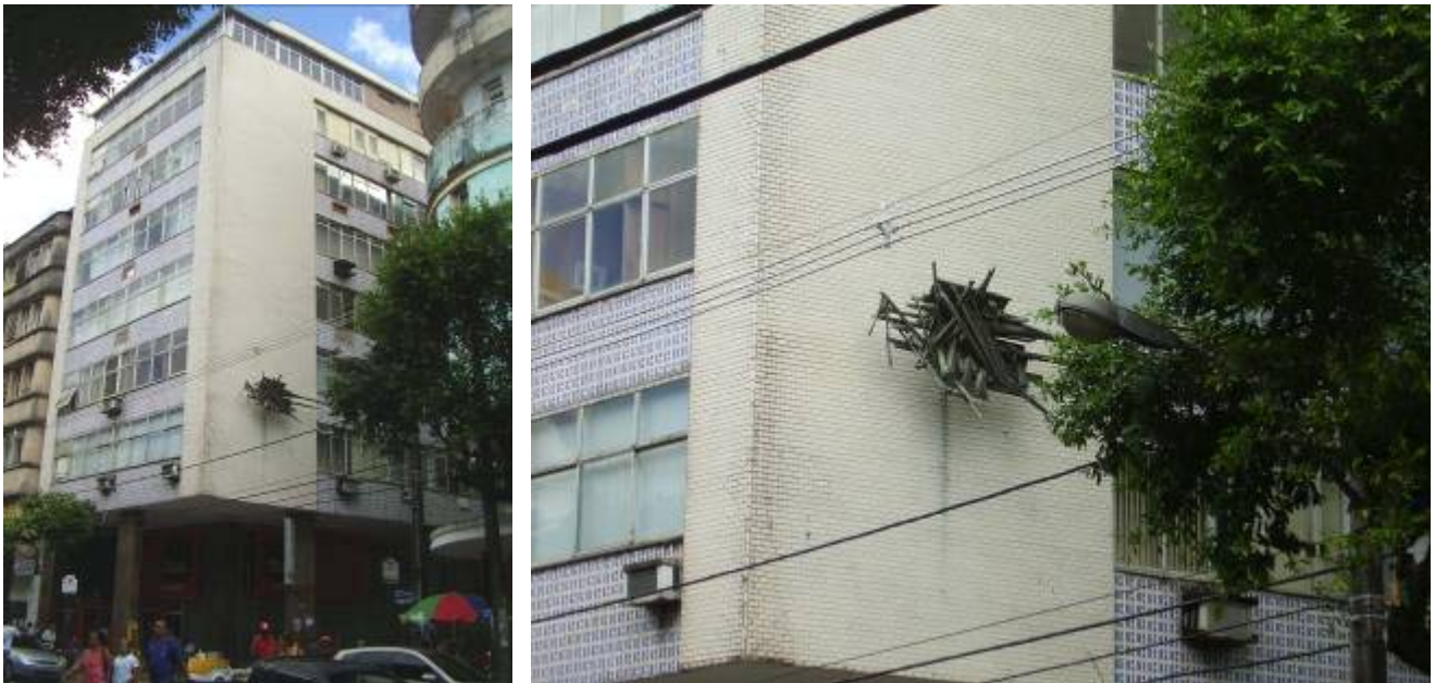
Figuras 17 e 18 – Vista geral do Edifício Barão de Cotegipe e vista em detalhe da escultura Ser com Antena de Mário Cravo Junior (fotos dos autores)
