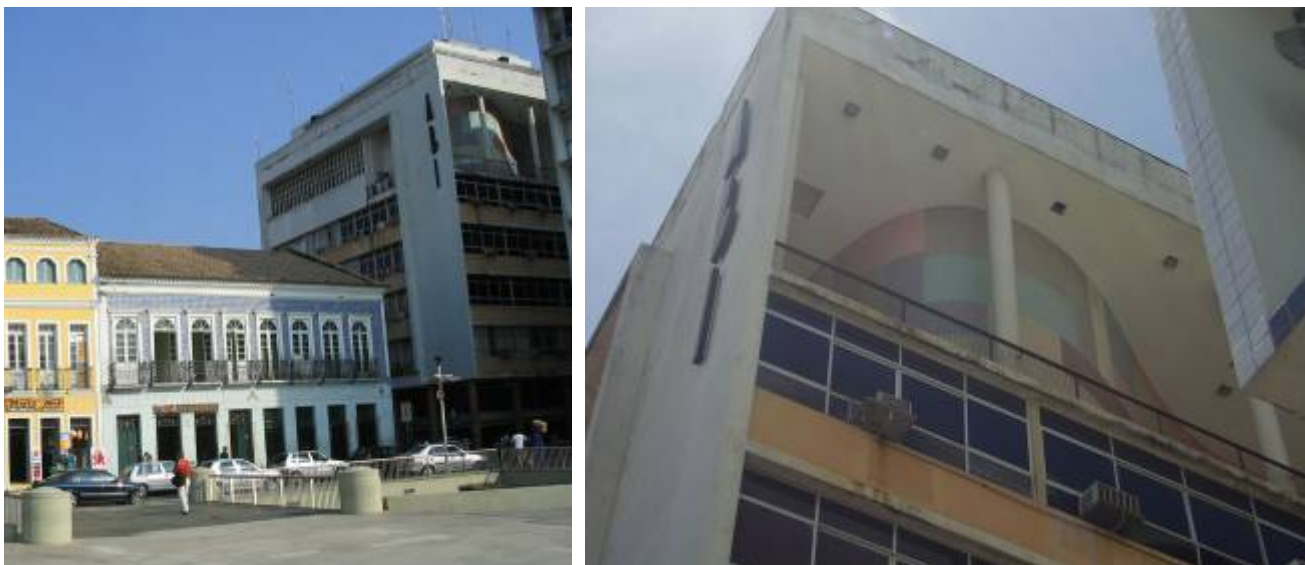
Figuras 15 e 16 – Vista geral do Edifício Ranulfo de Oliveira, sede da Associação Baiana de Imprensa, e vista em detalhe do painel em vidrottil de Mário Cravo Junior (fotos dos autores)
