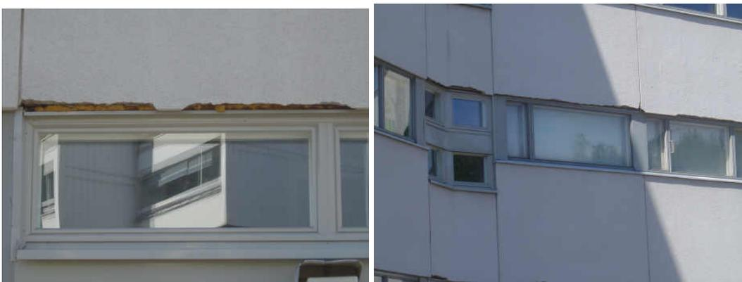
Fig.17 Pihlajamaki, fissuras nos painéis de concreto
