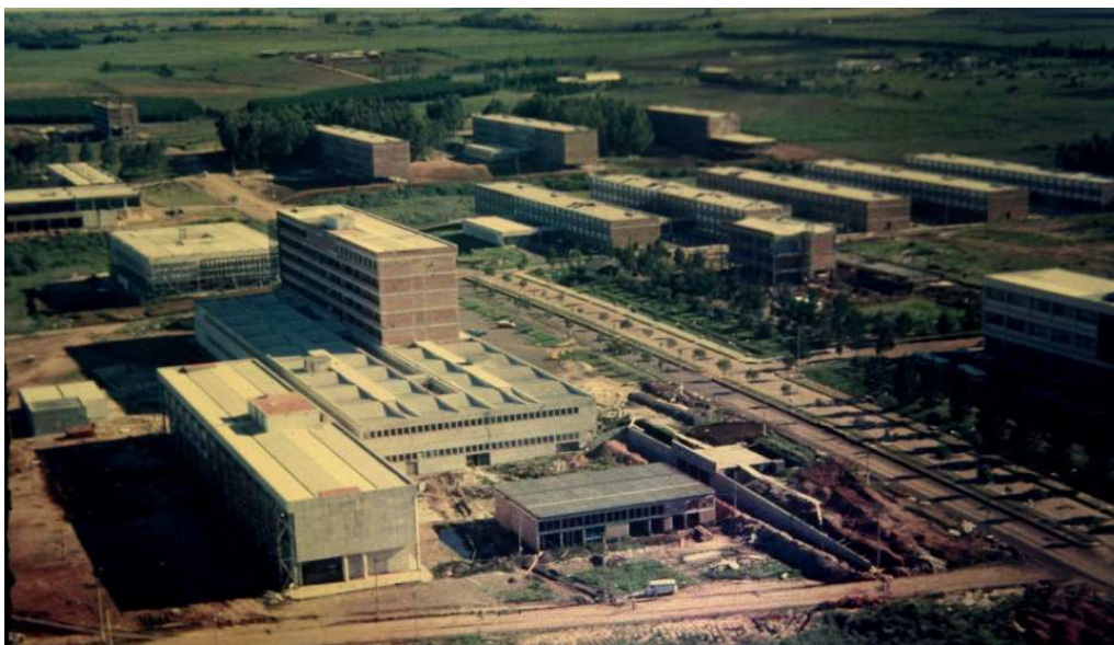
Fig. 1: Vista do campus da UFSM na década de 70 (Fonte: Acervo da UFSM, 2009)
