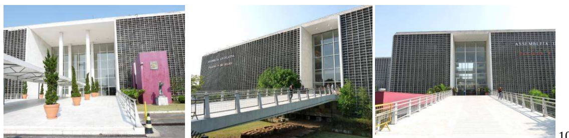
Fig. 10: Fotos acesso principal, de público e funcionários da ALESP em 2010 (Fonte: fotos Autor)
