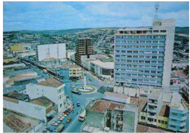
Figura 20: Vista parcial do centro de Campina Grande, vendo-se o Edifício Rique à direita. (Fonte: Arquivo de Antonio F. Bióca).
