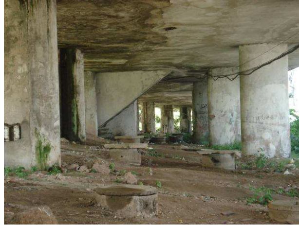
Figura 7. Vista parcial do Pavimento Térreo do Bloco A (Foto Concrejato)
