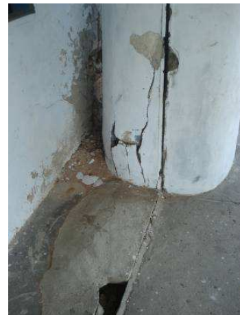
Figura 9. Detalhe da base do pilar no pavimento intermediário (Foto Concrejato)
