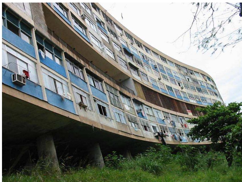
Figura 4. Foto da Fachada do Bloco A (Foto GAP)
