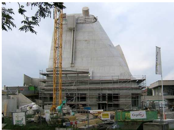
A igreja de Firminy em construção. Fonte: http://static.panoramio.com/photos/original/9226813.jpg Acesso dia 06/02/09
