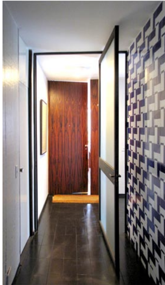
Fig.14 – Portas de piso a teto e com bandeira fixa em edifício residencial em Brasília (Mayumi e Sérgio Souza Lima, 1964)
