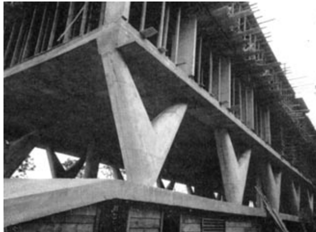
Fig.12 – Pilares em “V” no Hospital Sul-América, no Rio de Janeiro (Oscar Niemeyer, 1952)
