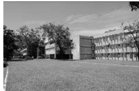
Figura 02: Vista externa do CAC. Fonte: Diogo Barretto
