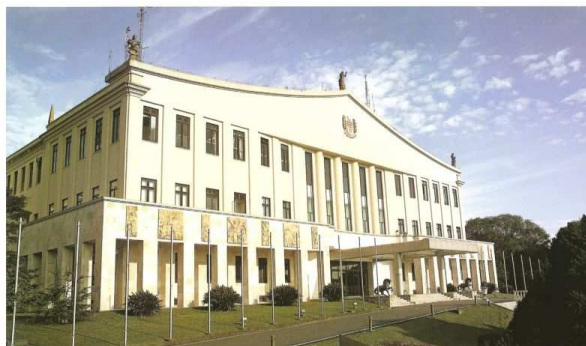
Figura 13: O corpo principal executado do palácio, com os painéis de terracota, o brasão paulista no frontão ligeiramente encurvado, suave concavidade no trecho central, e adição de marquise sobre a entrada (anos 1990). Fonte: Ponzoni Neto, Angelo et al. (orgs.) Acervo dos palácios do Governo do Estado de São Paulo . São Paulo: Imprensa Oficial, 2004.
