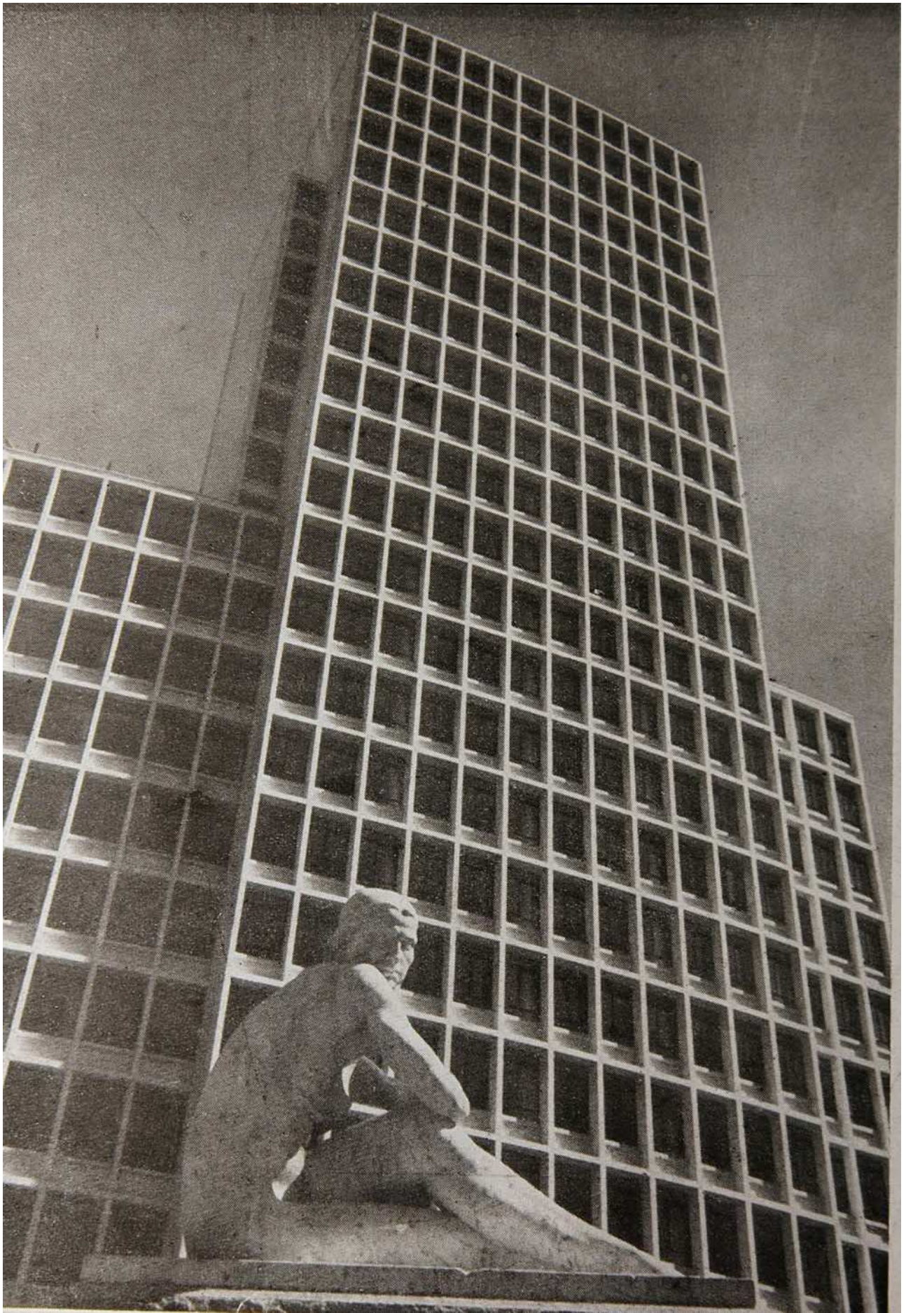
Figura 2 Edifício Thomaz Edison fonte Revista Acrópole 1948
