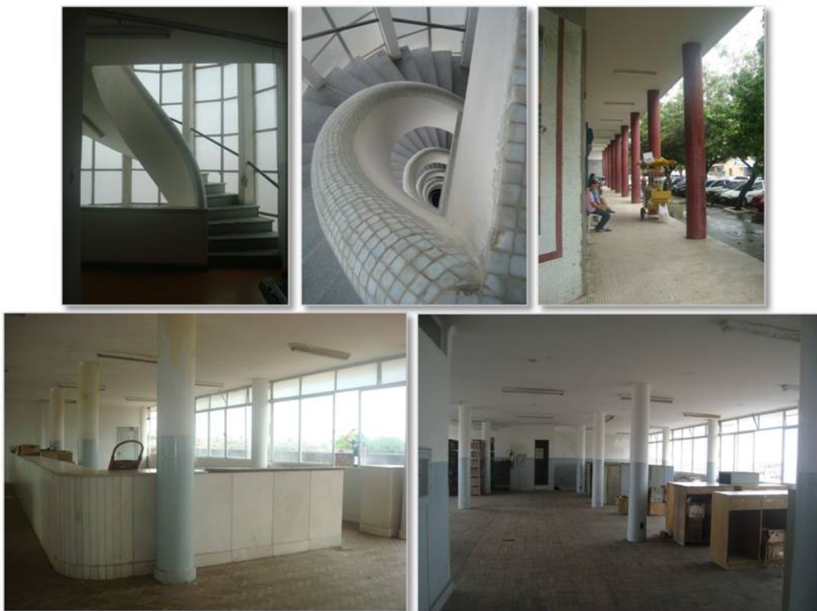
FIGURA 05. EDIFÍCIO DO IPASE EM NATAL – DETALHES Fonte: arquivo dos autores, 2009
