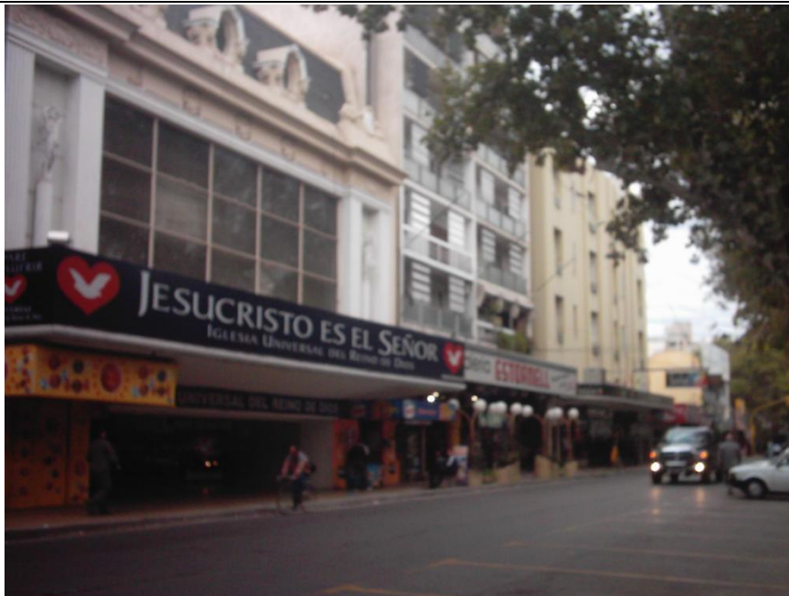
Figura 3- Fachada ex Cine Gran Rex. Calle Mitre Frente Plaza 25 de Mayo
