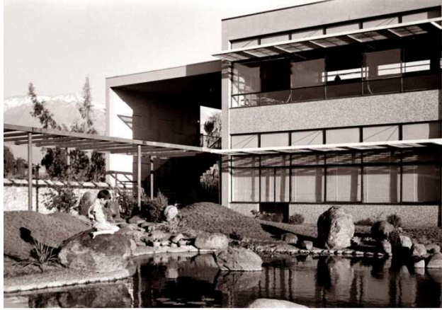
Pabellón de humanidades H 1-2 hacia 1962.
