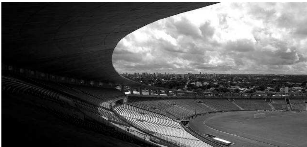
Figura 03. Vista interna do Estádio, ao fundo parte da cidade de Teresina. 2009. Fonte: fotografia Ana Negreiros Feitosa.
