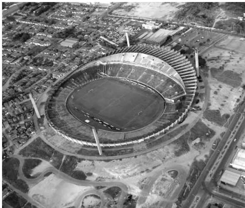
Figura 05. Vista aérea do estádio, em 01 de agosto de 2004. Fonte: acervo pessoal do Engenheiro Cid Castro Dias.
