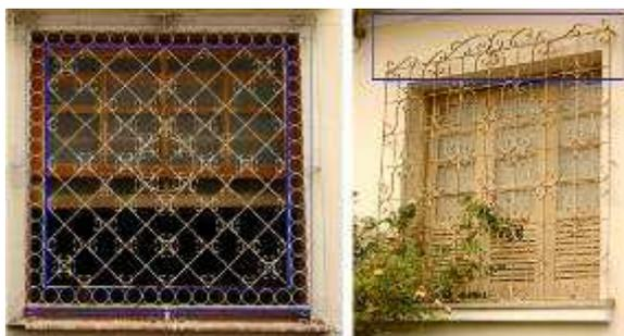
Figura 5 – Destacados em azul: moldura (à esquerda) e cabeçalho (à direita).
