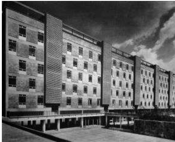
Figura 19: Fachada. Fuente: Arquitectura/México . Num. 67, México, D. F. 1959 p. 143
