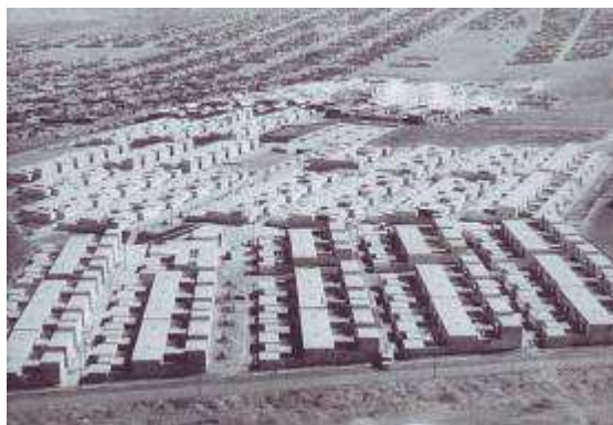
Figura 15. Vista General. Fuente: TORRENT, Horacio. Patrimonio de la Vivienda social en Chile en Seminario Sobre la Conservación y el Futuro de la Vivienda Social Moderna: Recopilación de documentos . Barcelona, España. DPA y Grupo Form. 2008
