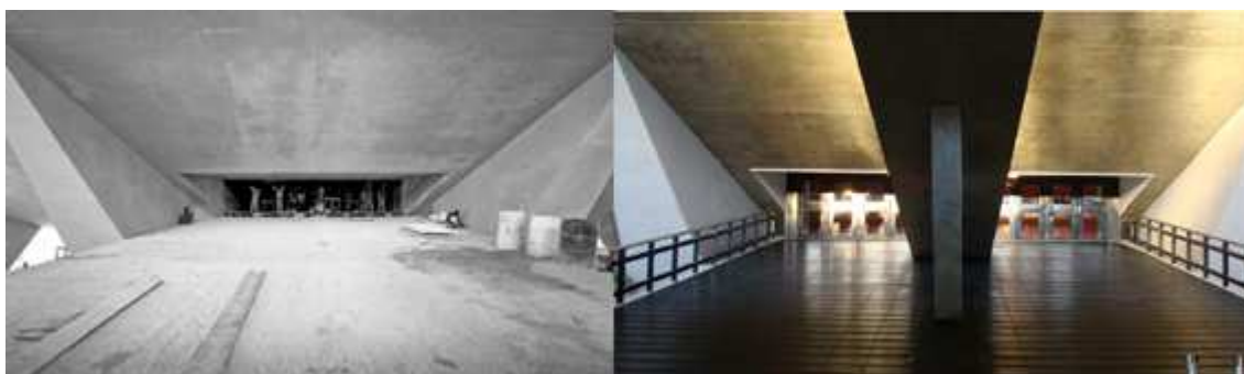
Figura 1: rampa do TCA em sua configuração original e depois da reforma de 1993, acrescida da "contra-rampa". Fotos: arquivo da Construtora Emílio Odebrecht e do autor.
