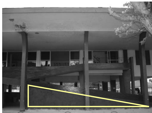
Fig. 6: Rampa de acesso com destaque para a parede de alvenaria que elimina o balanço. (Fonte: Samia Hohlenwerger)
