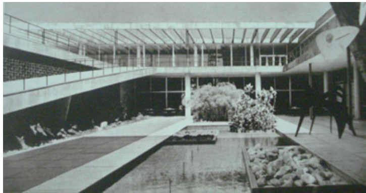
Figura 9: Pátio do bloco-Escola, com jardins de burle Marx; à direita, rampa de acesso ao terraço do restaurante. Vê-se o pergolado que o contorna. Fonte: Bonduki, 1999.
