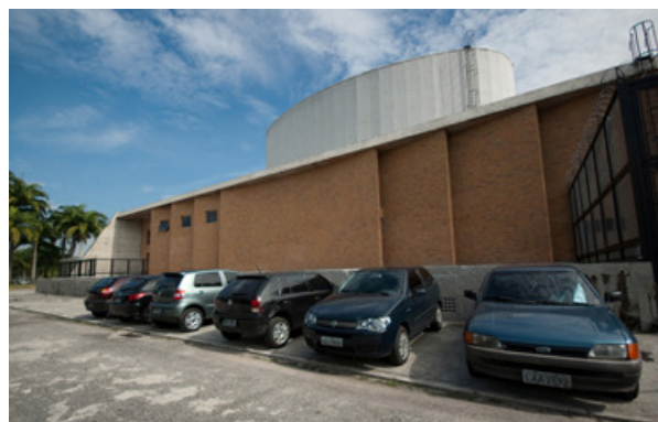
Figura 13: Fachada de tijolos do Vivo Rio. Fonte: Cinthia Serrano, 2009.
