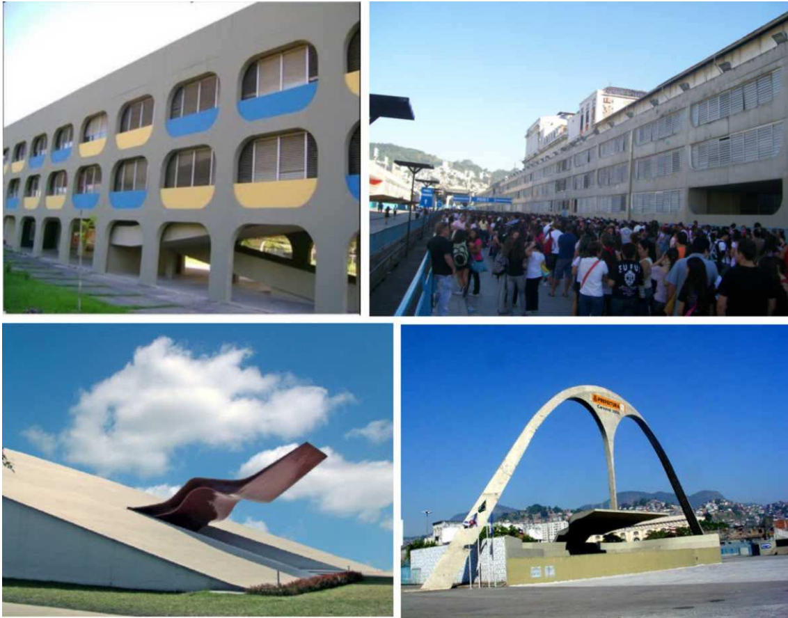
Fig. 2: Na seqüência: a) Fachada do CIEP Roberto Burle Marx; b) Módulos de camarotes da Passarela do Samba; c) Marquise do Teatro no Ibirapuera, em São Paulo; d) Museu do Carnaval, na Praça da Apoteose da Passarela do Samba.
