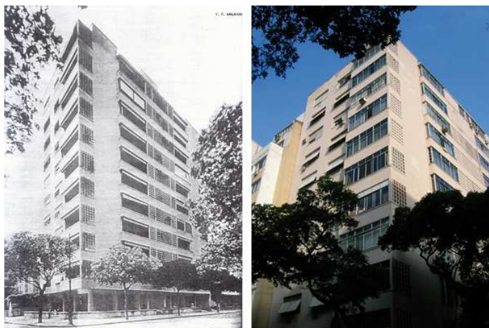
Fig. 3a - Fachadas déc. 1940. Fonte: Construtora AZEVEDO, MOURA & GERTUM (1948), fig. 3b - Fachadas atuais. Fonte: NUNES, D. (2008).
