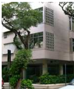
Fig 9 – Detalhe da esquina
