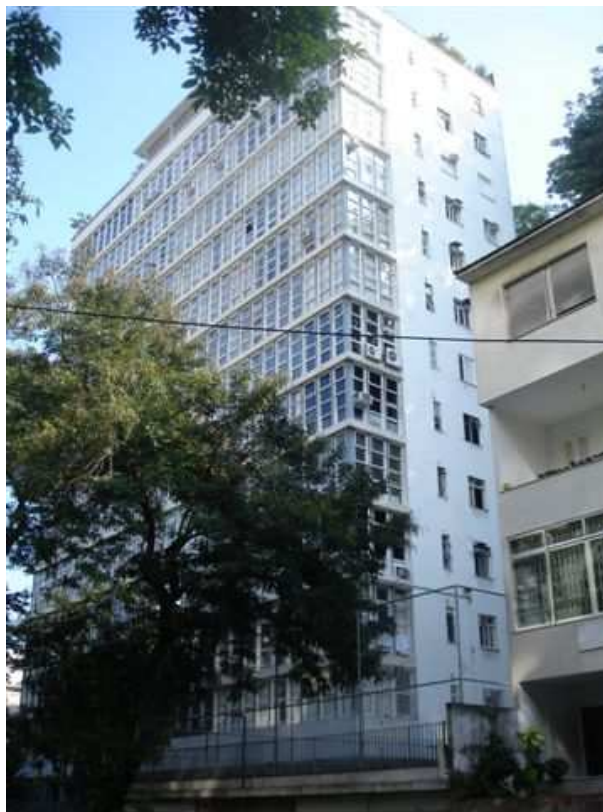
Figura 2 – Edifício Barão de Gravata Fonte: Foto do autor, maio 2009
