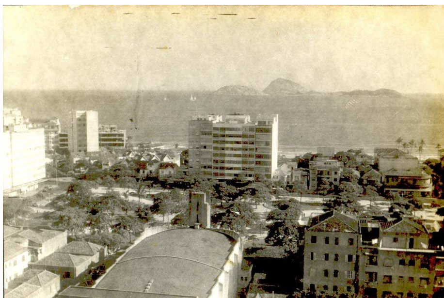
Figura 1 – Foto de Ipanema, vista da cobertura do edifício em obras, em 1958 Fonte: Coleção do autor
