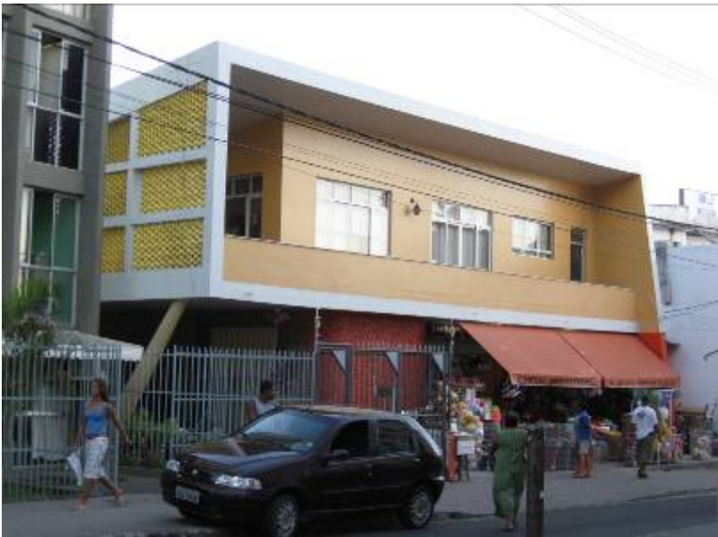
Figura 02 – Residência João Cordier à Rua Santos Dumont (Foto do autor, out./2008)
