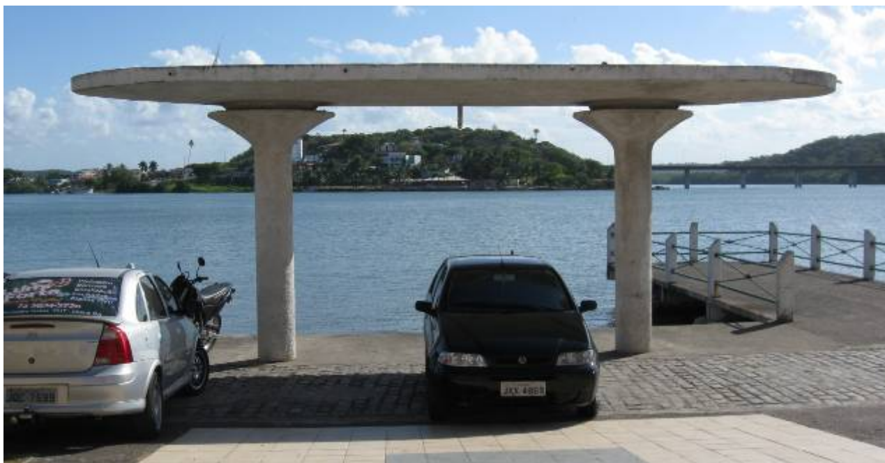
Figura 05 – Abrigo remanescente de antigo Terminal de Barcos na Avenida Dois de Julho, às margens da Baía do Pontal, em Ilhéus (Foto do autor, out./2008)
