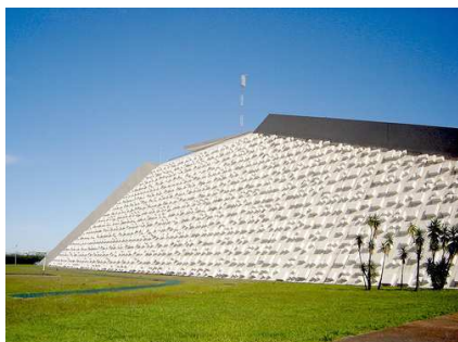
Figura 3: Fachada do Teatro Nacional. Fonte: http://farm2.static.flickr.com/1008/1385127496_c51fa90fb3.jpg?v=0
