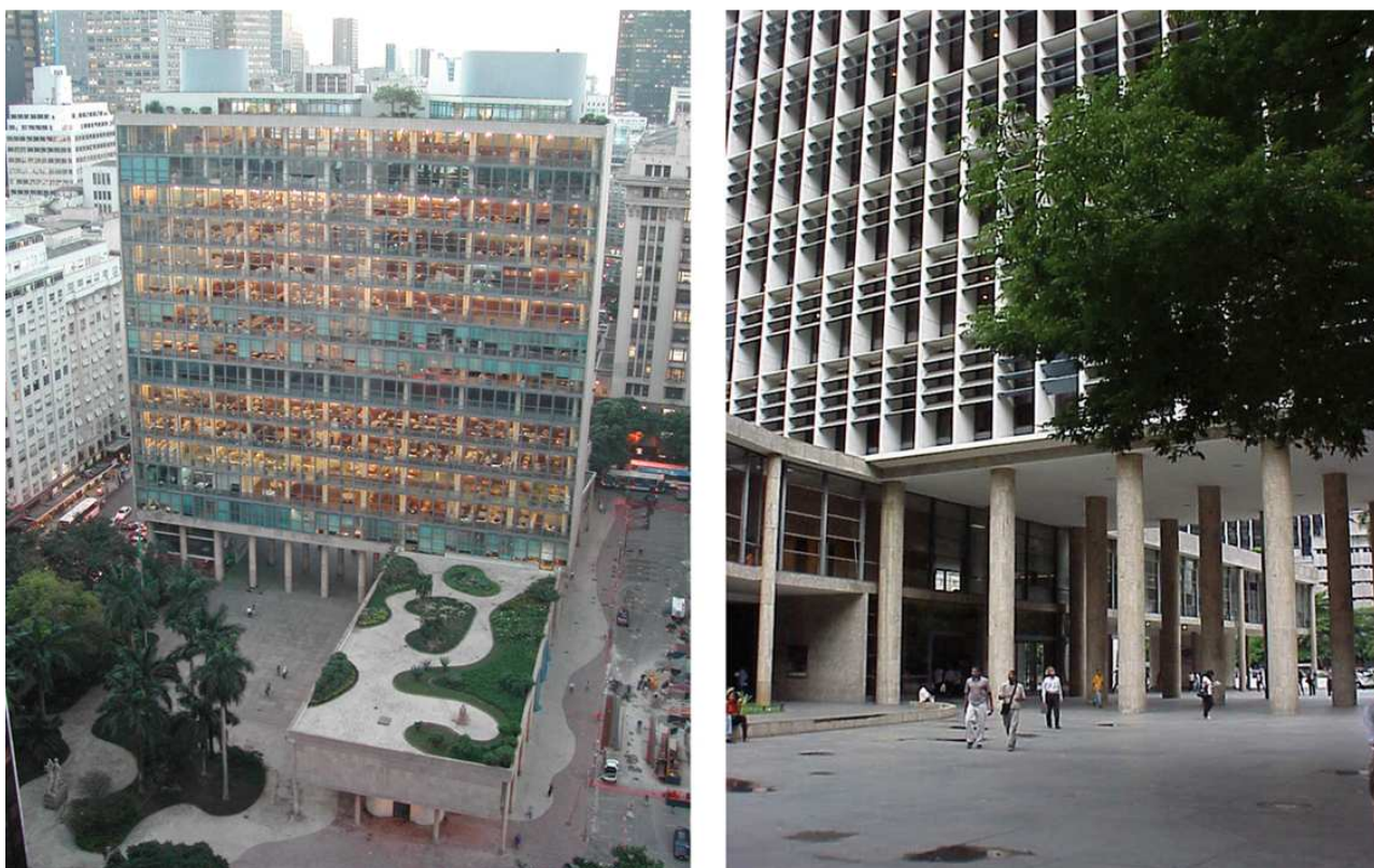
Fig. 3a e 3b. As fachadas do MESP: à esquerda, a fachada sul em curtain-wall , e à direita, a fachada norte com o sistema de brises para proteção solar.
