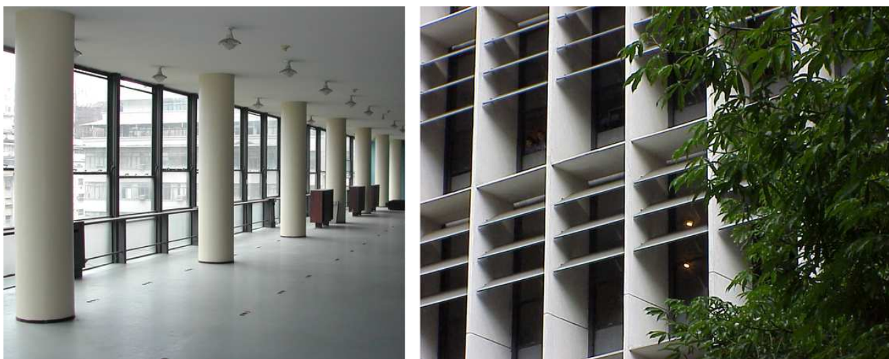
Figs. 4a e 4b. À esquerda, fotografia do interior do pavimento-tipo do MESP evidencia as soluções modulares presentes no sistema elétrico no piso e na distribuição das luminárias, além da adequada iluminação natural proveniente da curtain-wall da fachada sul. À direita, aspecto do sistema de proteção solar da fachada norte através dos brises.
