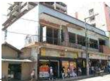
Fig. 11: Edifício da antiga sede do Clube Social. (Foto: Arquivo Pessoal Bruno Dalto, feita em 22 de agosto de 2010.) 12 Segundo dados do inventário do local da Secretaria de Patrimônio de Viçosa, o prédio foi construído para ser a sede do Vicoso Clube.
