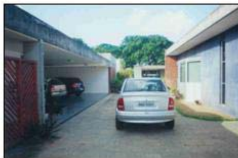
Figura 19 – Bloco de Garagem e serviços. 2003.
