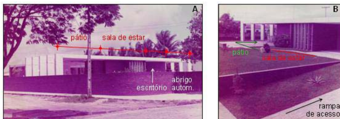
Figura 5 – A) Vista frontal da casa: predominância das linhas horizontais; B) Linhas verticais: os brises e pilares contrapõem-se à horizontalidade dominante; 1968.
