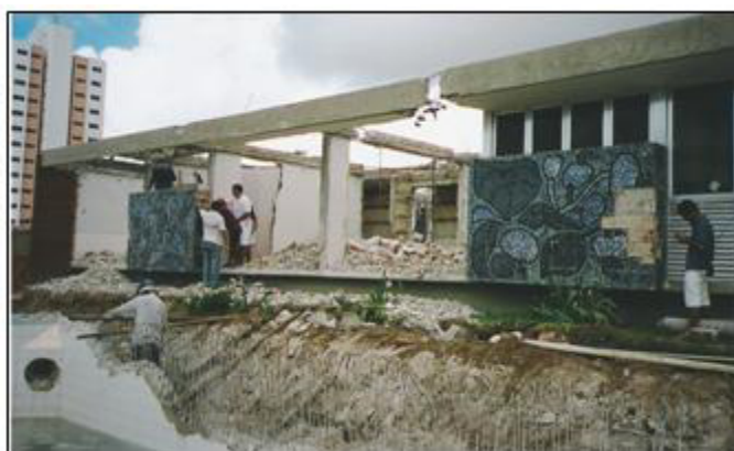
Figura 45 – Demolição (piscina e volume 3). 2005.
