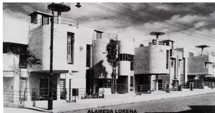
FIGURA 03. FOTO DAS CASAS VOLTADAS PARA A ALAMEDA PROJETO CONJUNTO DE CASAS DA ALAMEDA LORENA (1936)
