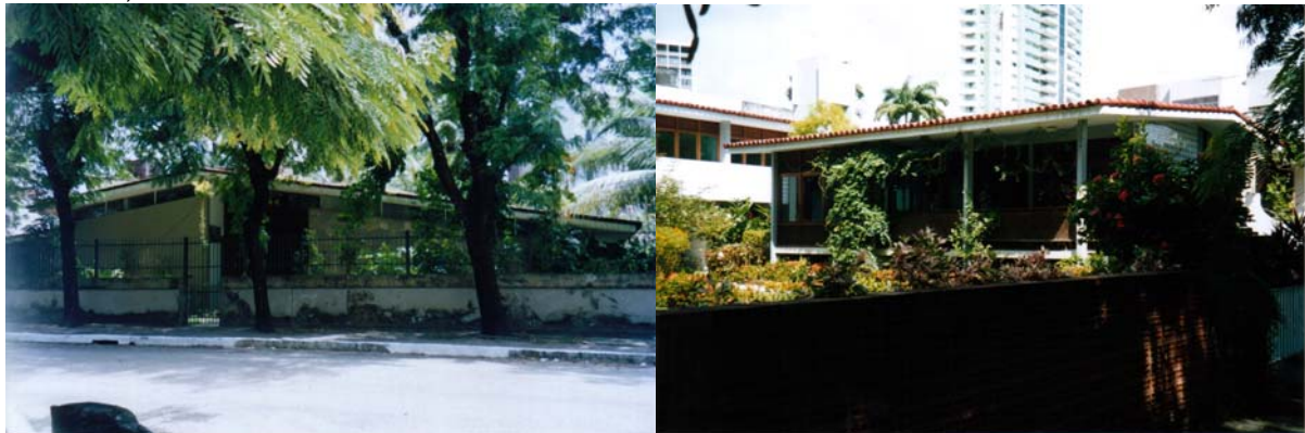
Residência Carlos Augusto Fernandes, 1963. “casa de Amorim” e Residência Eureles Cordeiro, casa de “Amorim” por Zildo Caldas e equipe, 1967. Fotos da autora.
