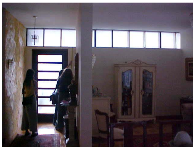
Figura 3: Vista interna da janela em fita. Fonte: Foto dos autores.
