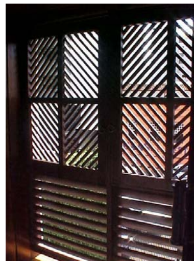
Figura 6: Vista externa e interna do muxarabi em madeira da fachada principal. Fonte: foto dos autores.
