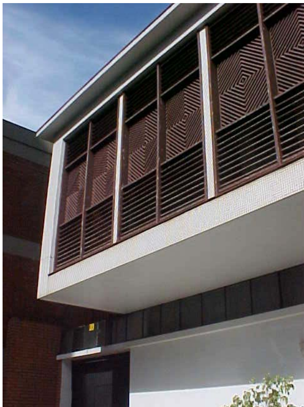
Figura 6: Vista externa e interna do muxarabi em madeira da fachada principal. Fonte: foto dos autores.
