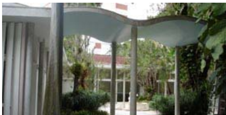
Fig. 03 – Laje do jardim e telhado ao fundo.
