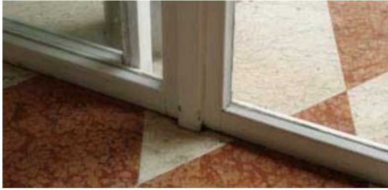
Fig. 12 – Base da esquadria de acesso ao pátio interno. Ótimo estado de conservação.
