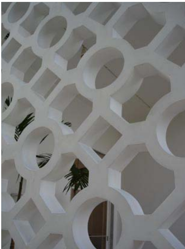
Fig. 17 – Parede vazada. Observe que não há emendas entre as partes.
