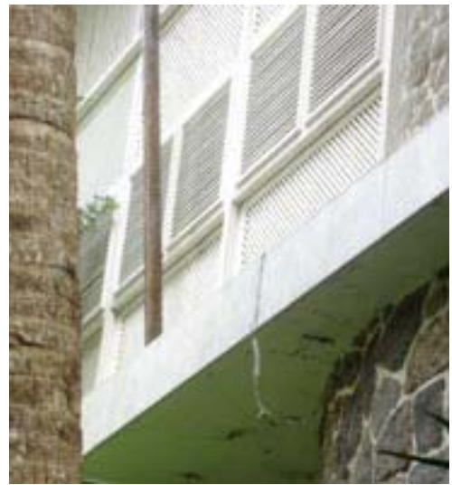
Fig. 14 – Esquadrias da ala dos quartos, também sob uma laje em balanço, mostrando bom estado de conservação.
