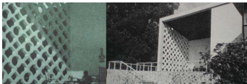
Fig. 01 – Fachada e detalhe da varanda.
