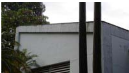
Fig. 06 – Empena em bom estado de conservação, graças à proteção do contorno saliente em mármore.
