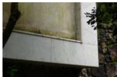
Fig. 07 – Manchas verdes na parte mais próxima do rio, na lateral da casa, devido à umidade mais intensa e acúmulo de água.
