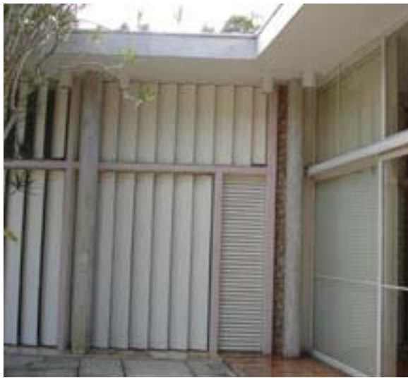
Fig. 13 – Brises, venezianas e esquadrias de acesso ao pátio sob balanço da laje que garante boa proteção à incidência de chuva.
