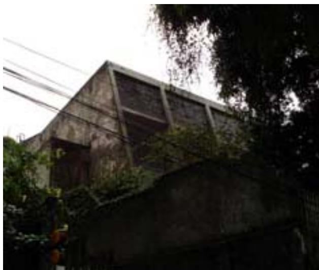
Fig. 25 – Aspecto geral da casa, com pintura do revestimento da empena lateral bastante comprometido em função da umidade.
