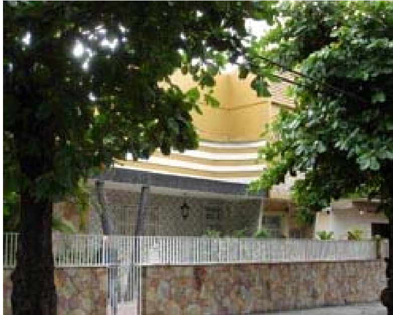
Fig. 35 – Bom estado de conservação dos revestimentos.
